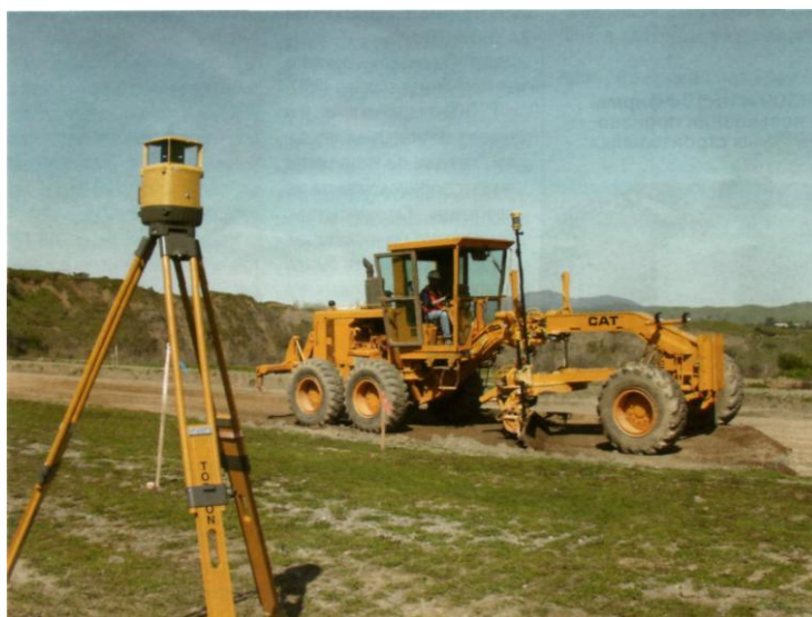
Рис. 14. Система RTK GPS совместно с лазерной системой Laser-Zone
