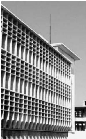
Рисунок 290 – Здание с вентилируемым фасадом в виде решетки
