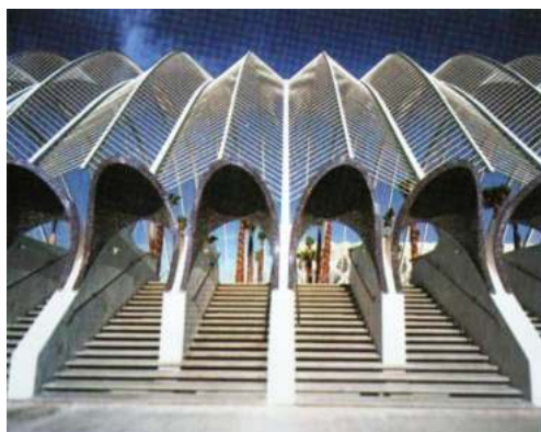
Рисунок 97 – Сборные складчатые конструкции
