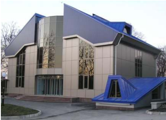
Рисунок 255 – Реконструкция загородного дома с обновлением фасада
