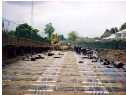
Рисунок 293 – Устройство георешетки на просадочных грунтах
