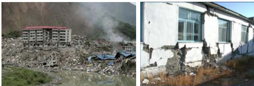
Рисунок 275 – Разрушение зданий в результате землетрясений
