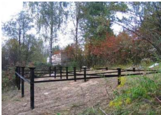
Рисунок 294 – Устройство фундаментов на просадочных грунтах
