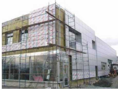
Рисунок 254 – Реконструкция фасада с утеплением и обшивкой сайдингом
