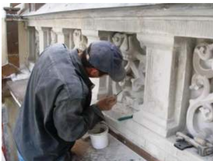
Рисунок 269 – Восстановление каменной резьбы
