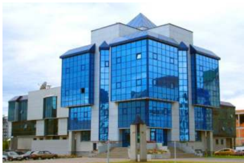
Рисунок 138 – Здание центрального отделения Сбербанка в г. Новокузнецке
