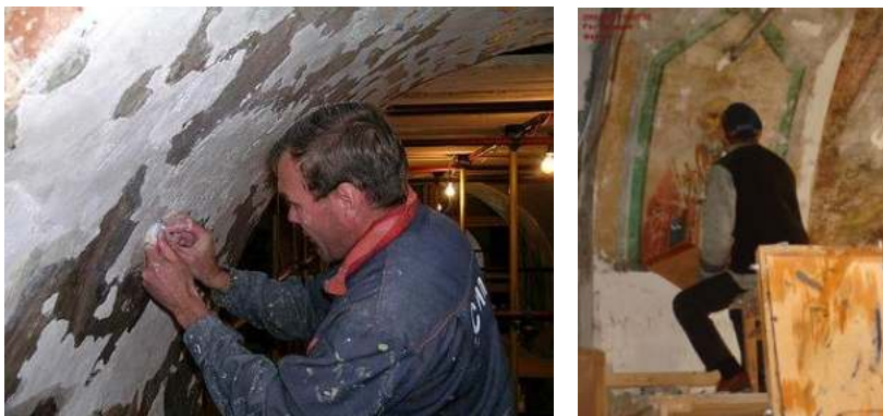
Рисунок 267 – Восстановление красочных поверхностей
