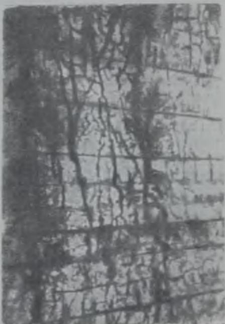
Рис. 7. Типичная сетка трещин в результате расширения бетона
