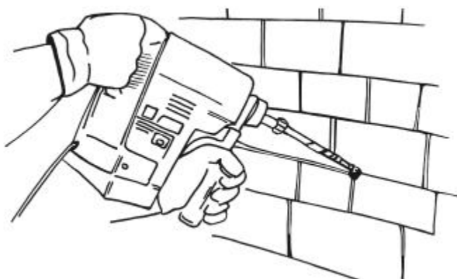
Рис. 6. Пробивание шпуров в кирпичной
