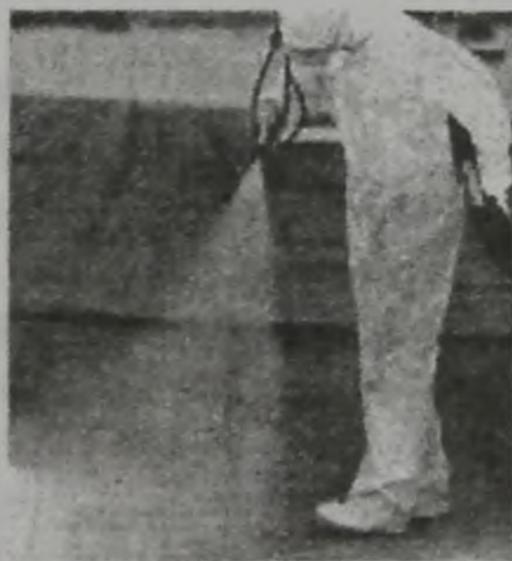
Рисунок 8 – Напыление изоляции
