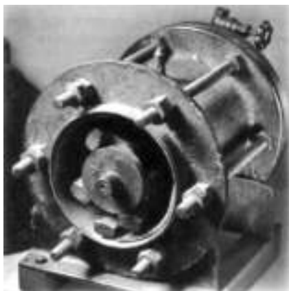
Предок современных размольных установок – дефибратор Арне Асплунда
