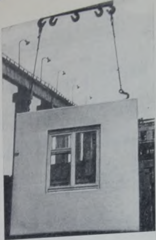
РИС. 55. СТЕНОВАЯ ОПЫТНАЯ ПАНЕЛЬ ИЗ НЕАВТОКЛАВНОГО ГАЗО-БЕТОНА
