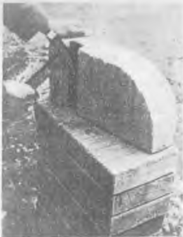
Рис. 17. Вырубка пазов в ячеистобетонных блоках специальным молотком
