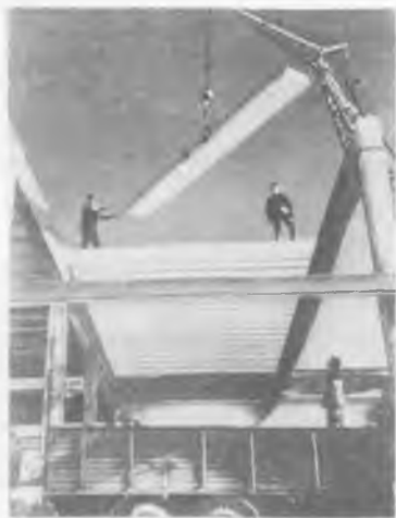
Рис. 105. Укладка ячеистобетонных плит в покрытие непосредственно с грузовика
