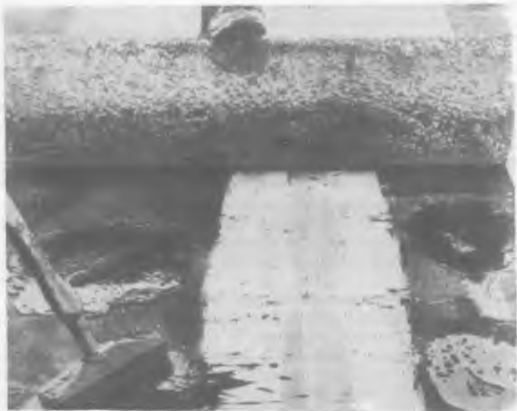
Рис.62. Точечное приклеивание кровельного ковра с посыпкой на внутренней поверхности для выравнивания давления пара между настилом и ковром
