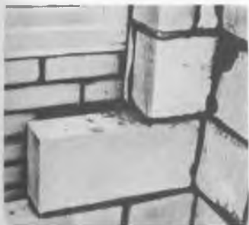
Рис.94. Конструкция пустотелой двуслойной стены с проволочными связями
