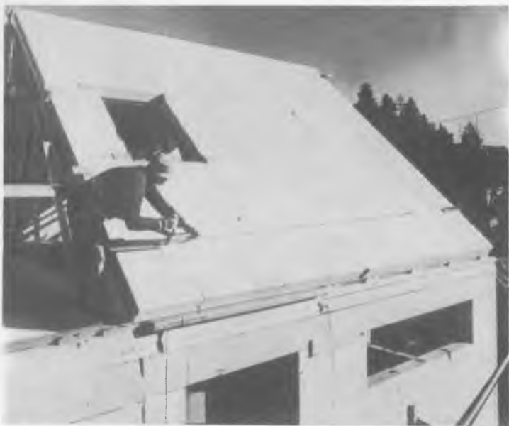
Рис.55. Самонесущая двускатная крыша из армированных ячеистобетонных плит
