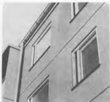
Рис.99. Ячеистобетонные стеновые панели размером на комнату, используемые в качестве несущих наружных стен (Швеция)
