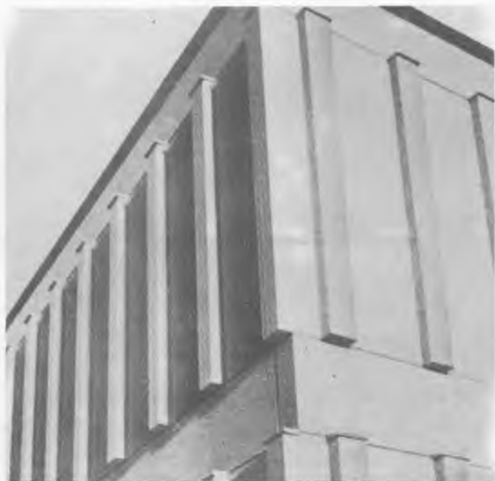
Рис.102. Стеновые элементы из ячеистого бетона (навешиваются с определенным шагом для создания архитектурного эффекта)
