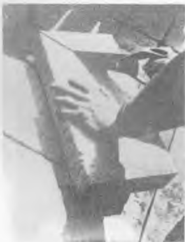
Рис. 15. Распиливание блоков из ячеистого бетона
