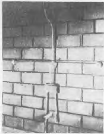
Рис. 18. Простота вырубки борозд позволяет выполнить скрытую электропроводку в любом месте стены
