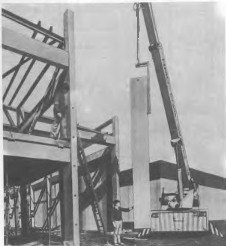
Рис. 51. Армированный ячеистобетонный вертикальный элемент, устанавливаемый в проектное положение при строительстве складских помещений (Великобритания)
