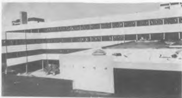
Рис.54. Применение ячеистого бетона в строительстве школьного здания (Великобритания)
