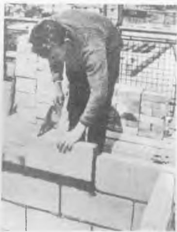
Рис. 16. Укладка ячеистобетонных блоков
