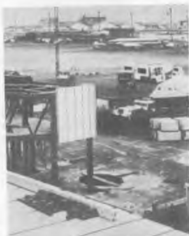
Рис.96. Ячеистобетонные плиты покрытия и вертикальные стеновые элементы в строительстве здания аэропорта (Англия)
