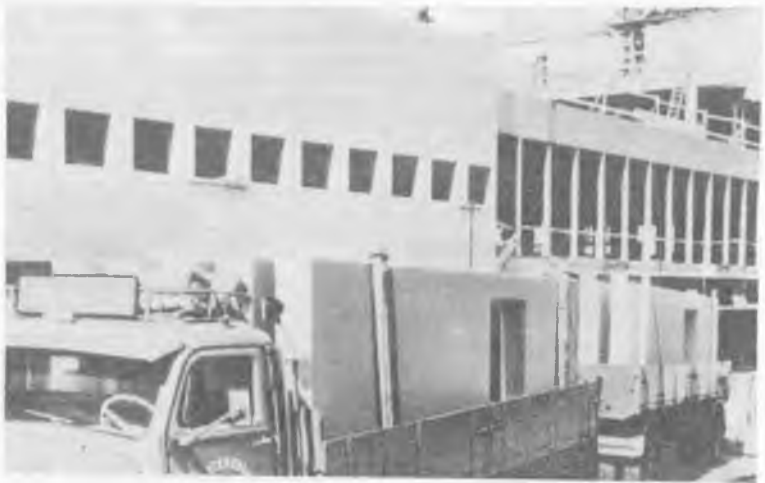
Рис. 31. Крупноразмерные стеновые панели из ячеистого бетона размером 1,5x6 м, используемые в качестве навесных стен (Швеция)
