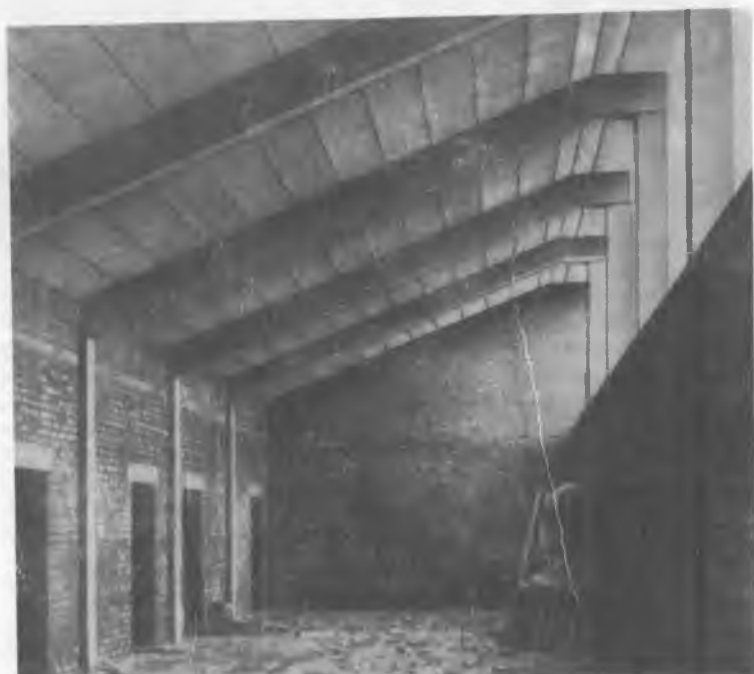
Рис. 64. Покрытие здания больницы плитами из ячеистого бетона (Великобритания)
