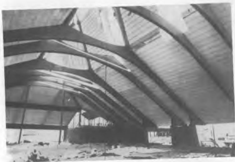
Рис.53. Ячеистобетонные плиты, открытые внутрь и уложенные на несущие деревянные конструкции (Канада)
