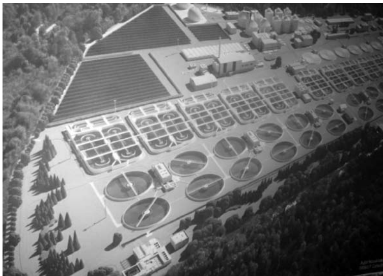
Фото 6.2. Очистные сооружения сточных вод г. Варшавы (Польша)
