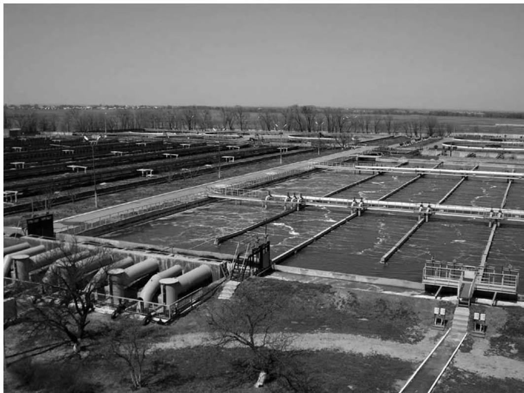
Фото 3.1. Станция аэрации г. Алматы, Казахстан
