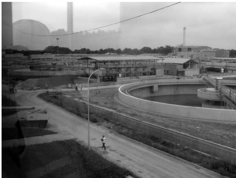
Фото 6.1. Очистные сооружения сточных вод г. Варшавы (Польша)
