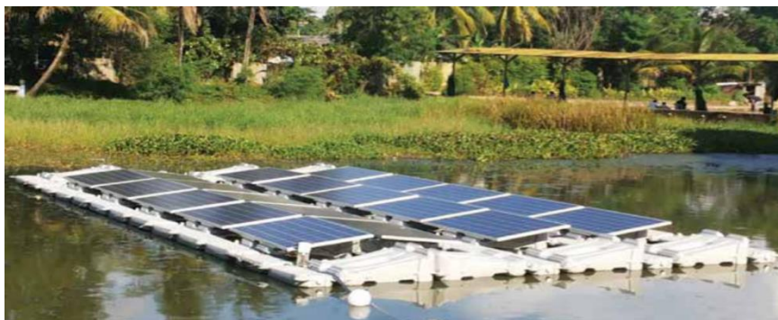
Рисунок 2 – Внешний вид солнечной электростанции на воде
