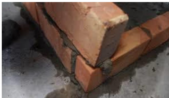
Рисунок 3 - Кирпичная кладка на ребро
