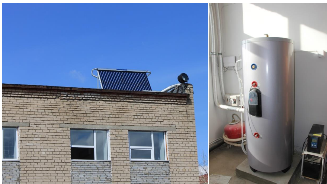
Рисунок 2- Солнечный водонагреватель на 200л
