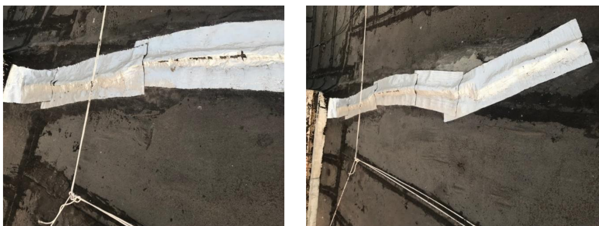
Рисунок 3 – Заделка трещин
