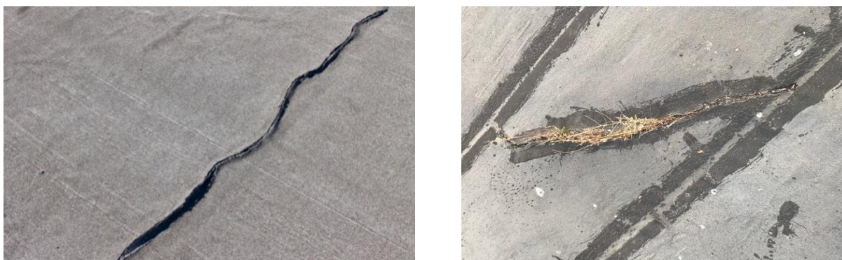
Рисунок 1 – Трещины на плоской кровле
