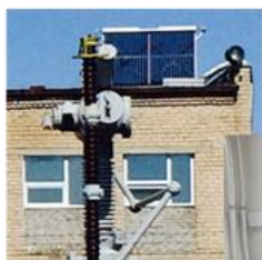
ВЕТРО-СОЛНЕЧНАЯ ЭЛЕКТРОСТАНЦИЯ С МОЩНОСТЬЮ 5 КВТ (2 КВТ-ВЕТЕР, 3 КВТ-СОЛНЦЕ)
