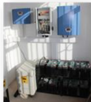
ВЕТРО-СОЛНЕЧНАЯ ЭЛЕКТРОСТАНЦИЯ С МОЩНОСТЬЮ 5 КВТ (2 КВТ-ВЕТЕР, 3 КВТ-СОЛНЦЕ)
