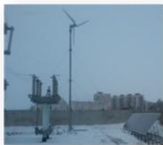
ВЕТРО-СОЛНЕЧНАЯ ЭЛЕКТРОСТАНЦИЯ С МОЩНОСТЬЮ 5 КВТ (2 КВТ-ВЕТЕР, 3 КВТ-СОЛНЦЕ)
