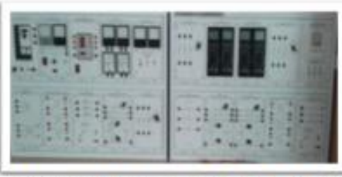
Системы энергосбережения промпредприятий
