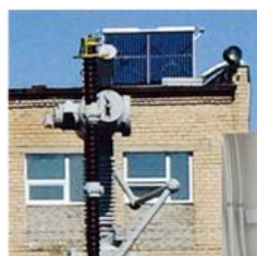
ВЕТРО-СОЛНЕЧНАЯ ЭЛЕКТРОСТАНЦИЯ С МОЩНОСТЬЮ 5 КВТ (2 КВТ-ВЕТЕР, 3 КВТ-СОЛНЦЕ)
