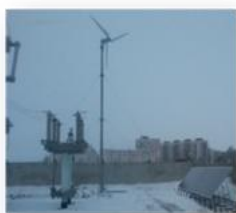
ВЕТРО-СОЛНЕЧНАЯ ЭЛЕКТРОСТАНЦИЯ С МОЩНОСТЬЮ 5 КВТ (2 КВТ-ВЕТЕР, 3 КВТ-СОЛНЦЕ)
