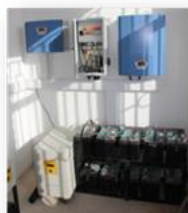
ВЕТРО-СОЛНЕЧНАЯ ЭЛЕКТРОСТАНЦИЯ С МОЩНОСТЬЮ 5 КВТ (2 КВТ-ВЕТЕР, 3 КВТ-СОЛНЦЕ)
