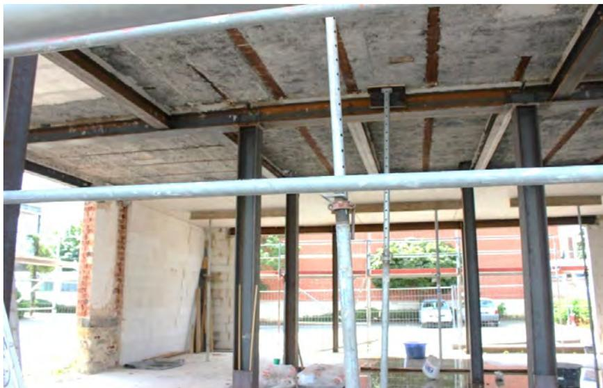
Рисунок 2 – Замена несущих конструкций первого этажа реконструируемого здания
