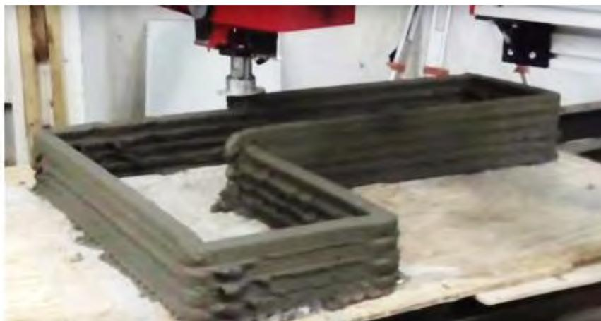
Рисунок 1 – Контурная 3D-печать конструкции
