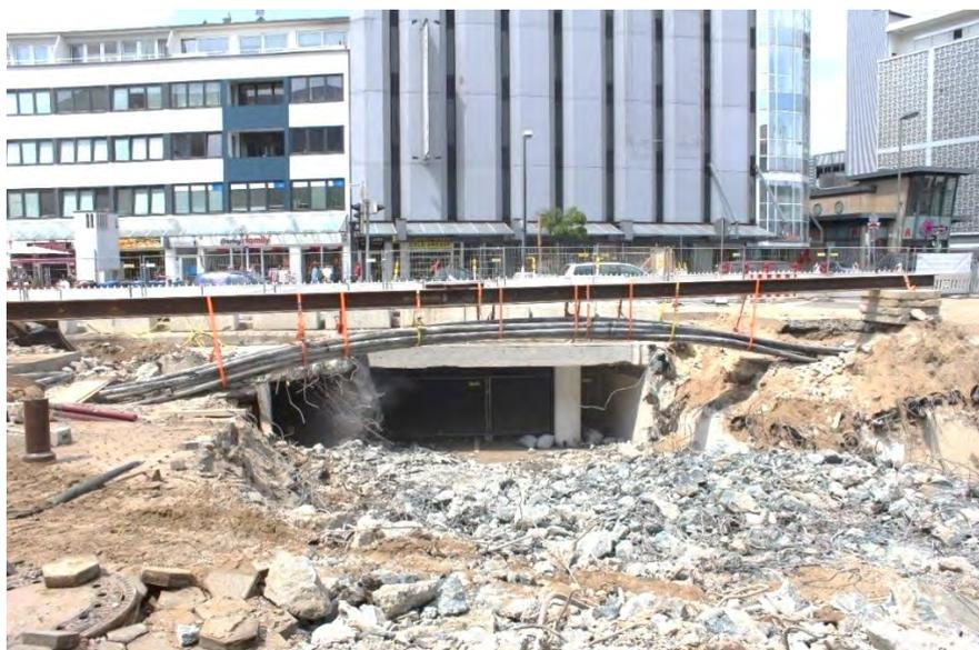
Рисунок 8 – Установка дополнительных несущих конструкций для переброски коммуникаций связи и электрических сетей
