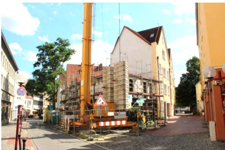
Рисунок 1 – Установка башенного крана в стесненных условиях
