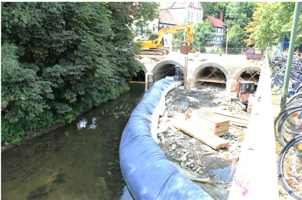
Рисунок 4 – Решение вопросов гидроизоляции участка реконструкции
