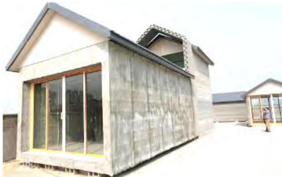
Рисунок 3 – Дом, напечатанный по контурной технологии компанией WinSun
