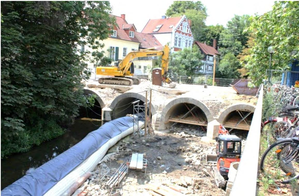
Рисунок 3 –Использование гибкого трубопровода для осушения участка реконструкции моста
