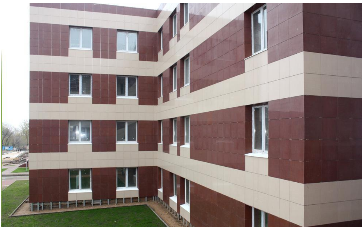
Рисунок 14 – Отделка фасада керамогранитом
