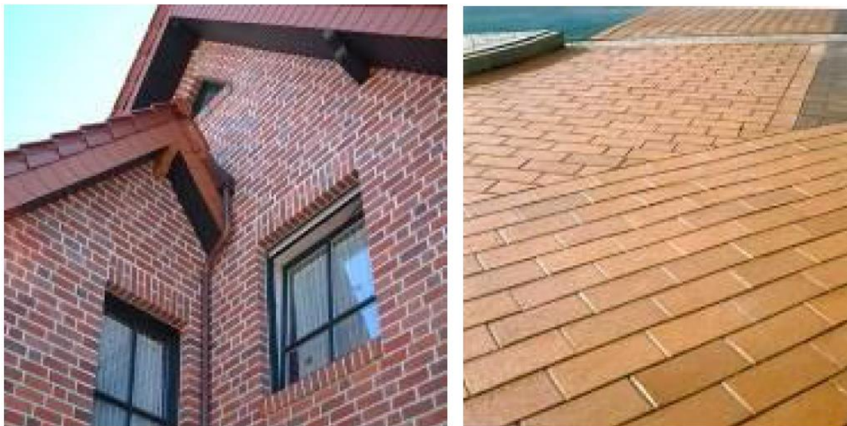
Рисунок 22 – Фасад здания (слева) и тротуарная дорожка (справа), выложенные из клинкерного кирпича
