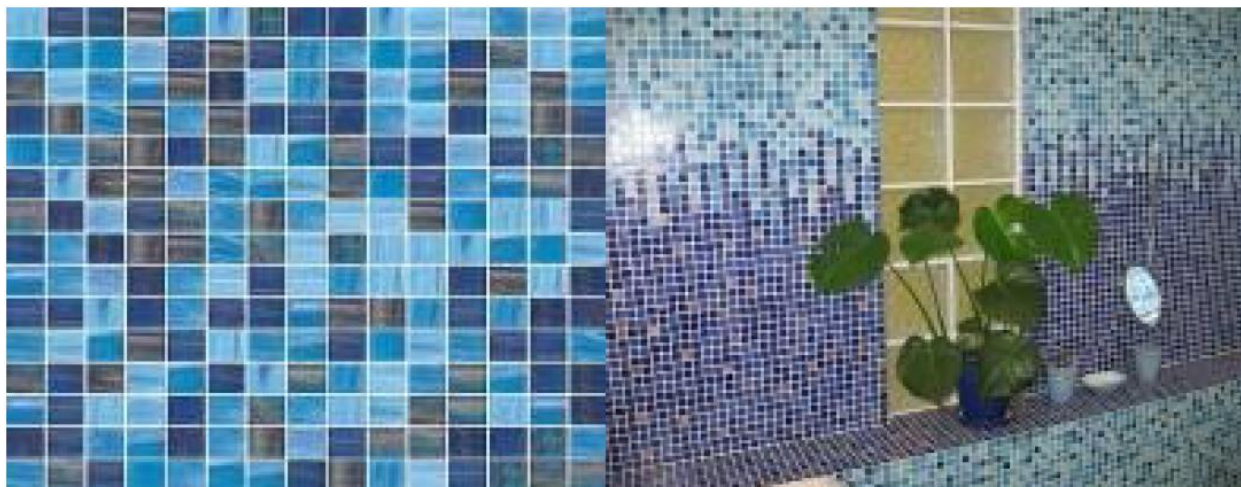
Рисунок 15 – Мозаичный ковер из мелкоформатных плиток (слева) и стена, облицованная ковровой керамикой (справа)
