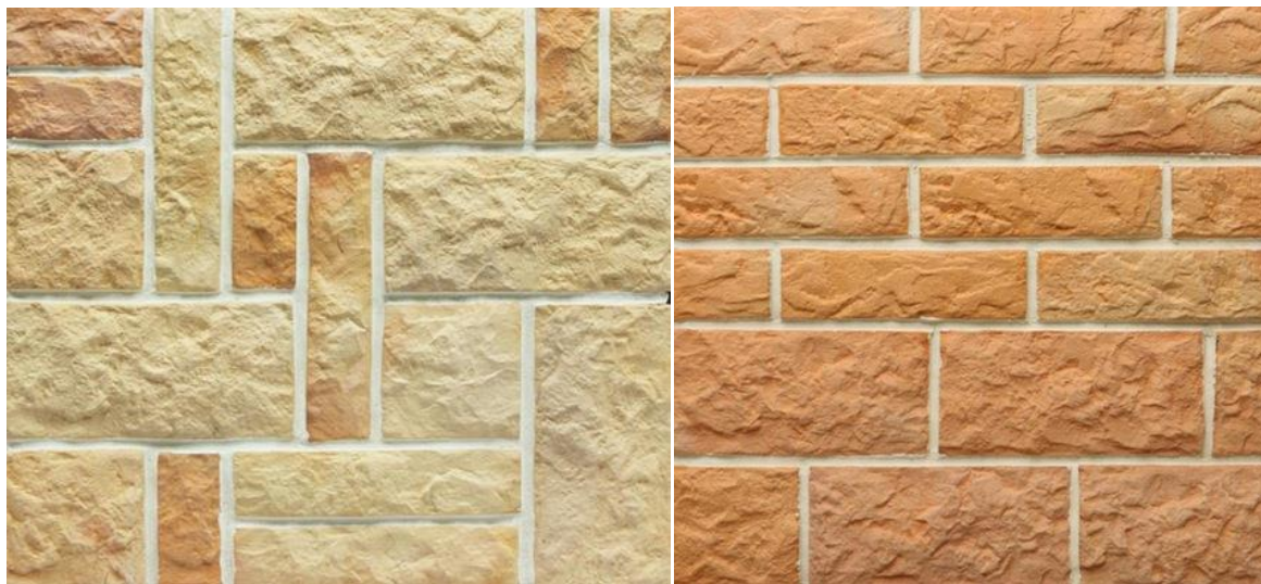
Рисунок 16 – Архитектурная терракотовая отделка
